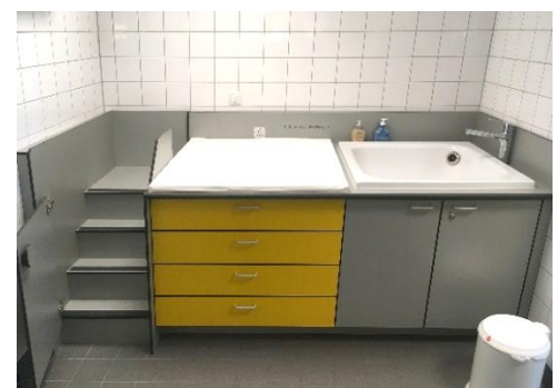
Wickeltisch mit Duschwanne und fester Treppe
